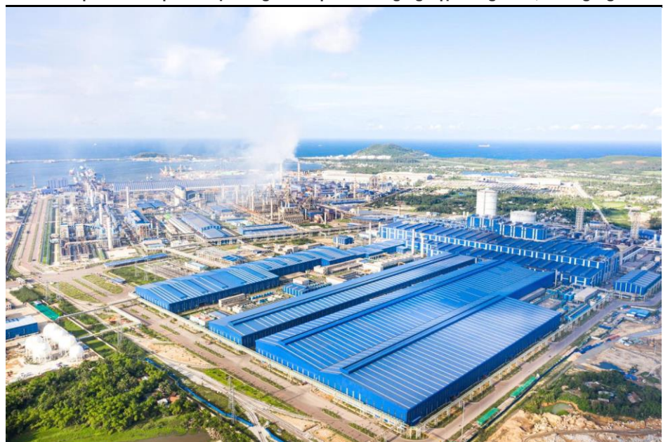
Hình 11: Dự án siêu dự án thép Dung Quất tại khu công nghiệp Dung Quất, Quảng Ngãi
